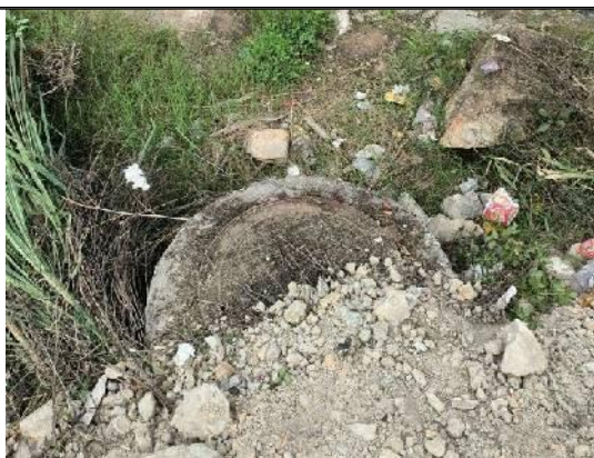
生活污水纳管口
