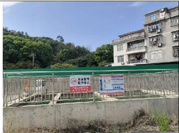
雨水三级沉淀池
