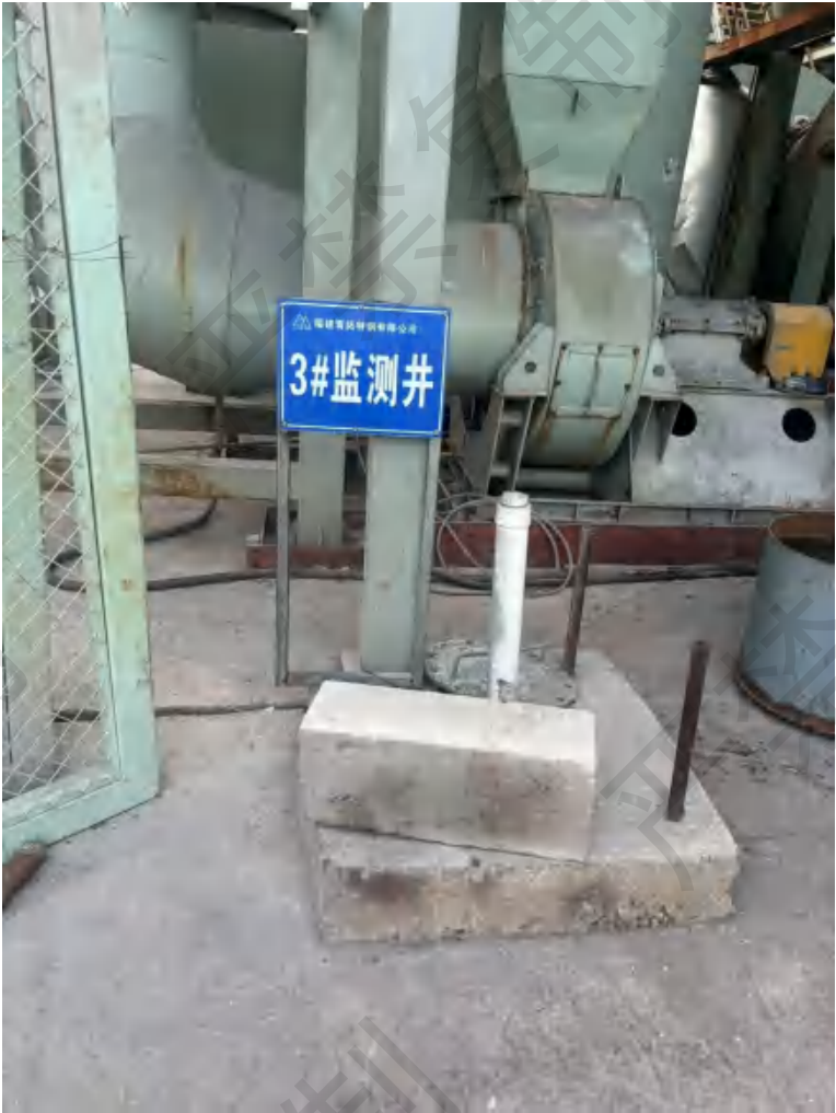
图 4.5-1 已按环评要求建设一个地下水监控井
