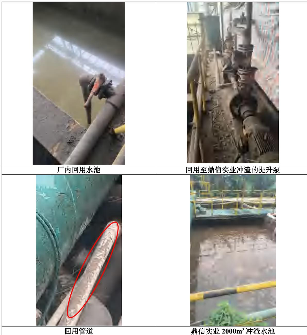
图 4.3-2 酸性废水回用管线与回用去向
