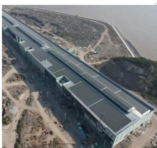
光伏屋面一体化
